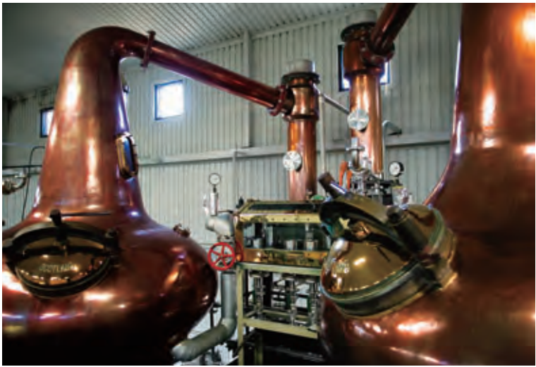
単式蒸溜器（ポットスチル）はスコットランド製で、くびれがないストレート型。デザイン自体は、この蒸溜所オリジナルの形です。
