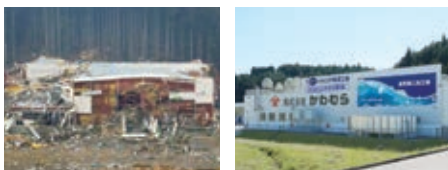
東日本大震災で被災した岩手第二加工場とその復旧後
