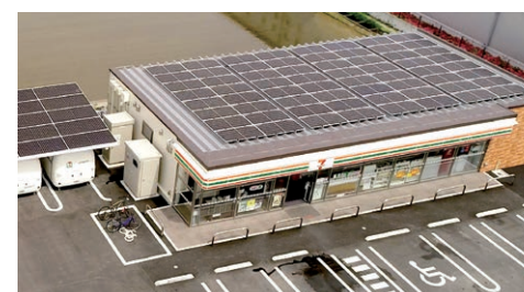
電力使用量・店舗内外温度の計測・分析などを行うエネルギー管理システム(EMS)や、可動式蓄電池(バッテリーキューブ)の導入、ソーラーカーポートの設置など設備構成の最適化により、購入電力量は2013年度対比で約60%削減、CO 2 排出量は約70%削減可能となったセブン・イレブン三郷彦成2丁目店。
